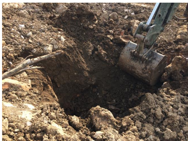
Fotografija 6: Izvedba istražnog raskopa za uzorkovanje u dubljim slojevima tla
