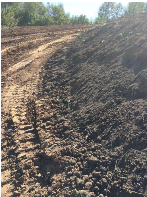
Fotografija 6: Područje izgradnje fugase
