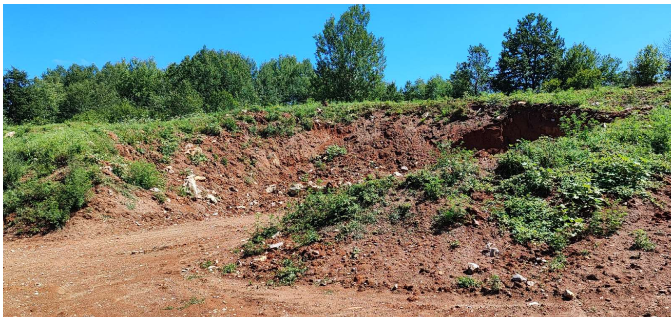
Fotografija 3: Lokacija Drenovica – fugasa
